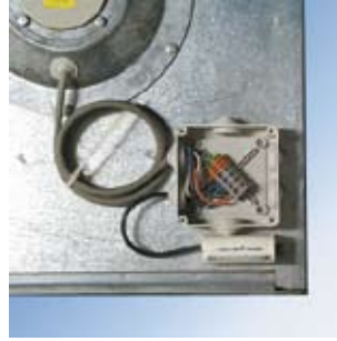
podłączenie silników do listw zaciskowych ułatwiające instalację
